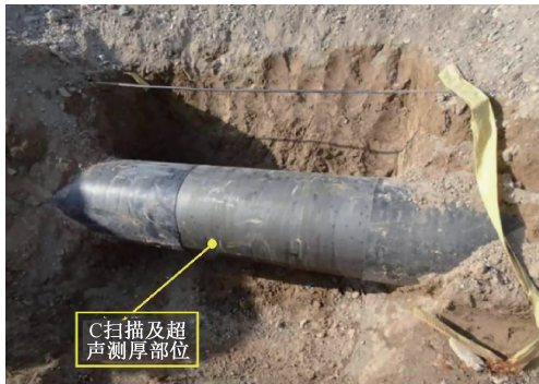
图10 管道开挖检测位置
